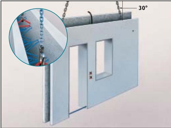
Gehänge und Lot von  $30^\circ$  zu gewährleisten, ist ein ausreichend langes Gehänge zu verwenden. Verbleibende Elemente gegen Kippen sichern. Dann Sicherungsbolzen des zu entladenden Elementes entfernen. Langsam und nicht ruckartig, anheben, dabei plötzliche Bewegungen vermeiden. Auf waagerechte Lage (Kettenzug) achten. Gegebenenfalls mit Ausgleichsgehänge für große Elemente mit vier Abhebern arbeiten.
